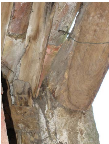
Detalles do aleiro e paredes costais de táboas verticais sobre bastidores horizontais
