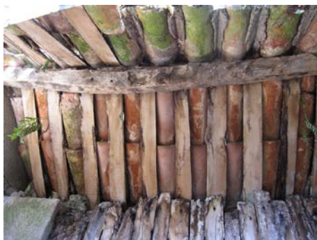
Detalles da armazón de madeira da cuberta
