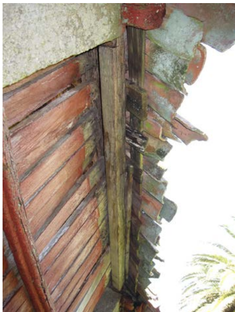
Detalles do aleiro e paredes costais de táboas verticais sobre bastidores horizontais
