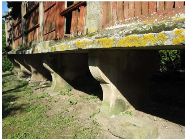
Detalle das cepas de suspensión e base da cámara
