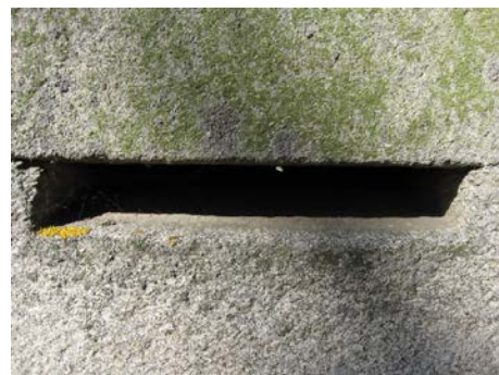
Detalle abertura de ventilación (doelas)
