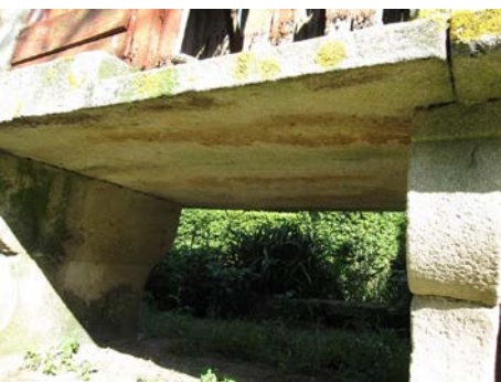
Detalle das cepas de suspensión e base da cámara
